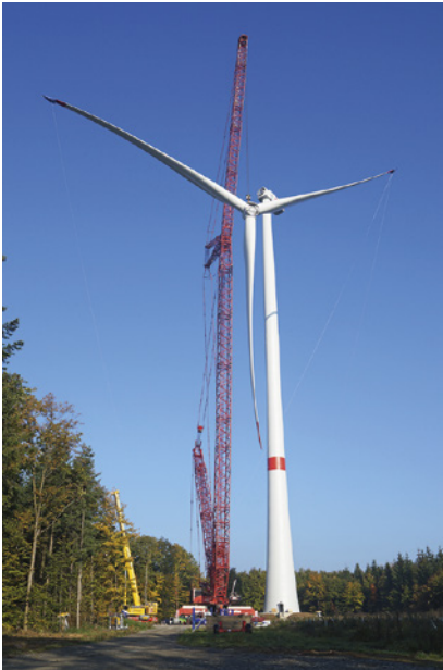
Abb. 2: Montage des insgesamt 65 Tonnen schweren Rotors an den Turm einer Windkraftanlage im Windpark „Großer Wald“.
