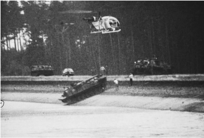
Vom Sinn und Nutzen eines Bergepanzers für den Dammbau. Szene aus einem Super-8-Film über den Rettungseinsatz vom 18. Juli 1976. (StAL FT-346-Uwe Stockhaus.)
