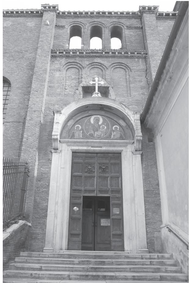
Abb. 5: Rom, S. Maria in Aracoeli, Reste des Glockenturms des 12. Jhs. mit nachträglich eingebrochenem Südeingang, Mauerwerkresten in Falsa cortina des 12. Jhs. und Baufuge zum Querhaus (Foto Mondini 2009)
